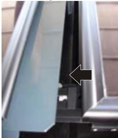
**i** Door de verticale speling van de aansluitplaat heeft men toegang tot de hydraulische aansluitingen en kunnen de zonnecollectoren bevestigd worden.
