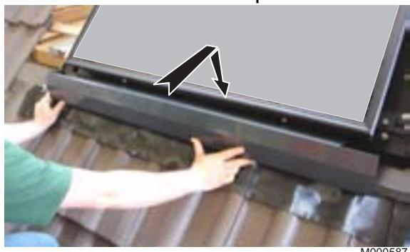
8. Die Schrauben anziehen, um das Gehäuse zu fixieren. Nicht vollständig festziehen, um die Position des Gehäuses nach Abschluss der Montage anpassen zu können.
